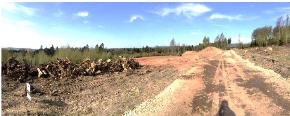
Abbildung 24: Windkraftbaustelle im Naturpark Kaufunger Wald (Hessen, 2016)
